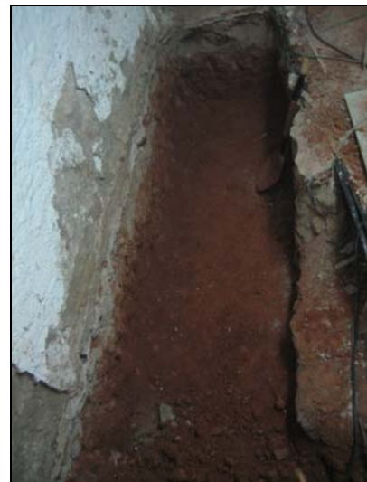
FOTO 4. Rasa arran de paret per recalçar l'estructura.
