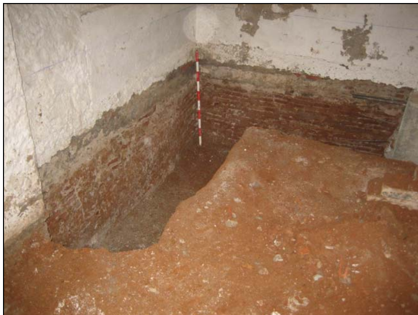
FOTO 7. A la part sud-oest del soterrani, presència d'una fonamentació prèvia corresponent al segle XX.
