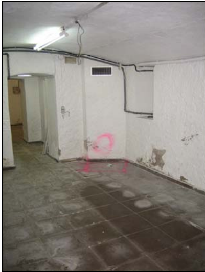
FOTO 1. Aspecte del soterrani abans de la intervenció.
