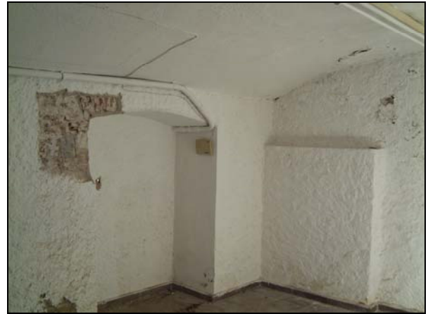
FOTO 2. Vista del soterrani.
